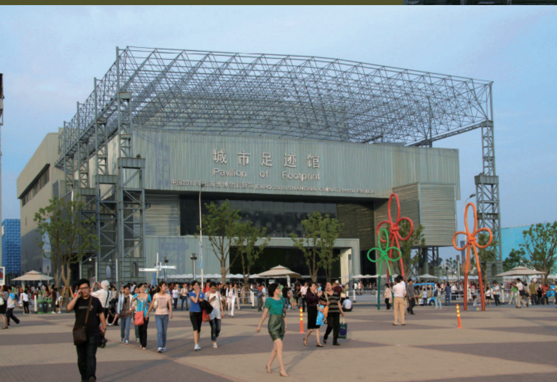
2010年6月5日上海世界博览会 城市足迹馆
